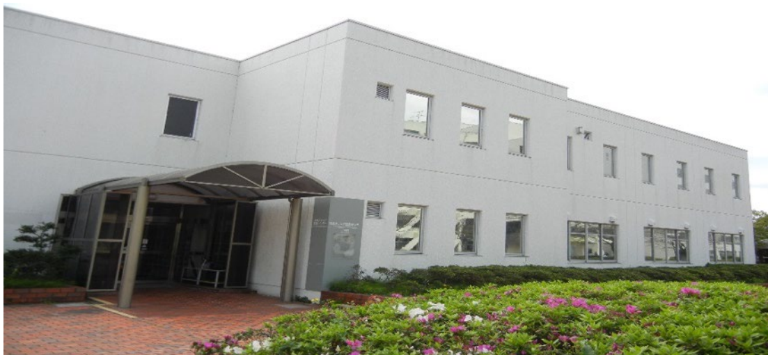
図 2. 情報メディア基盤センター外観
